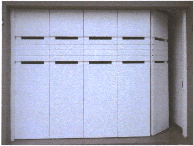
Gambar 2.12; Pintu Pagar Besi
