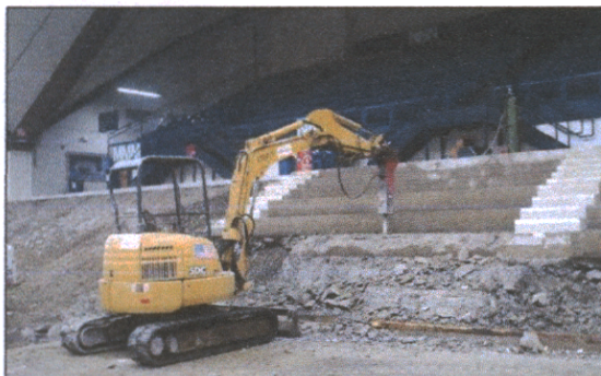
Gambar 3.3; hydraulic stone breake pada pembongkaran Gedung
