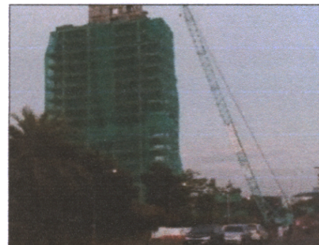
Gambar 3.4; crane pada pembongkarangn gedung
